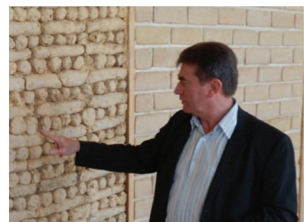
Le maire présente les murs intérieurs en bauge, pisé et briques de terre crue.
