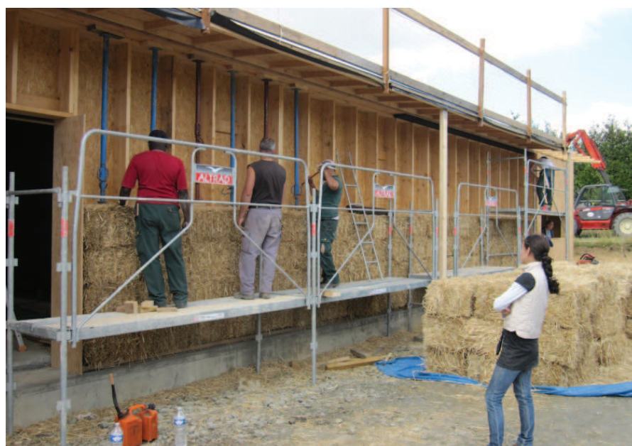
Le chantier de pose de l'isolation paille. Au final, 7% de la population de Mouais a participé à la construction de la salle
