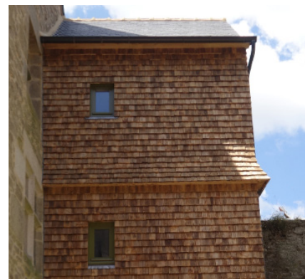
L'extension bois, en place des anciennes latrines, abrite l'élévateur et les sanitaires
