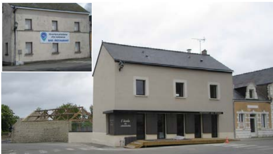
Vue du dernier commerce qui ouvrira prochainement à Eancé, et de son logement à l'étage après travaux. En vignette, le bâtiment avant travaux.
