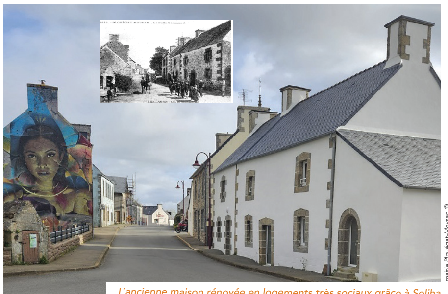
L'ancienne maison rénovée en logements très sociaux grâce à Soliha
