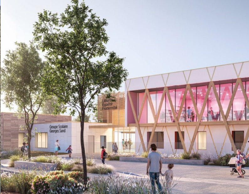
Construction du Pôle élémentaire - Saint-Mars-du-Désert © PADW Architectes
