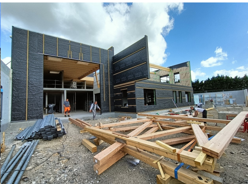
Chantier de construction du Pôle élémentaire Saint-Mars-du-Désert © CC Erdre et Gesvres
