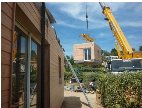
Construction hors site et tri des déchets
