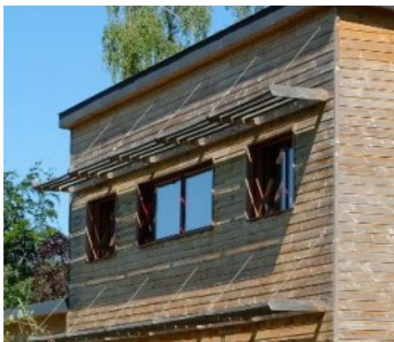
Exemple de brises-soleil et de stores extérieurs
