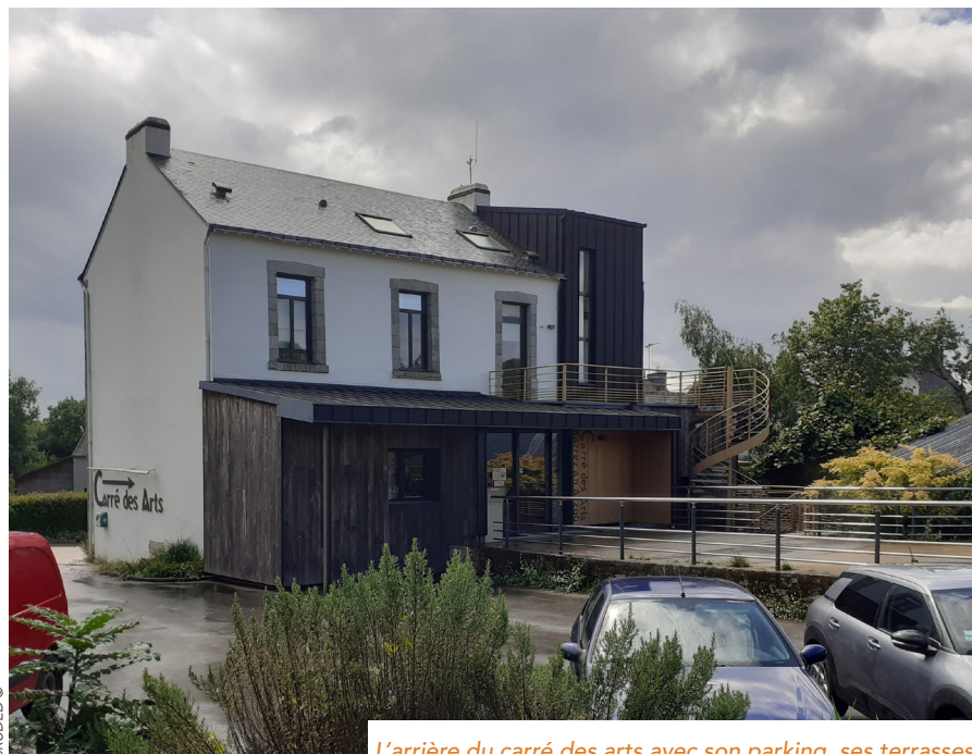
L'arrière du carré des arts avec son parking, ses terrasses.
