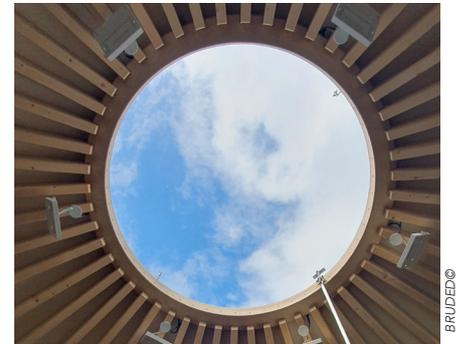
Le dôme central apporte une grande luminosité et un système pour l'obturer va être mis en place pour éviter les surchauffes.
