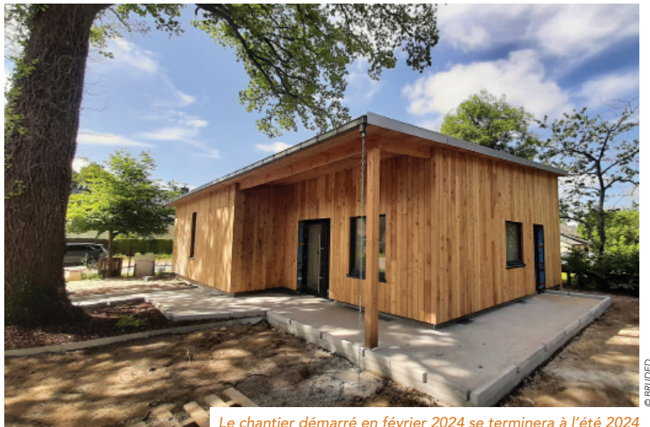
Le chantier démarré en février 2024 se terminera à l'été 2024
