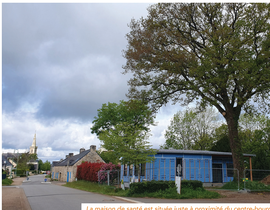
La maison de santé est située juste à proximité du centre-bourg
