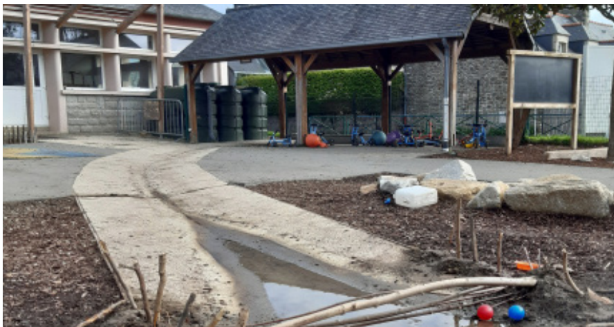
L'eau pluviale des toitures est récupérée dans des citernes. Le trop-plein est renvoyé dans une grande noue via des rigoles en béton érodé qui traversent la cour d'école.
