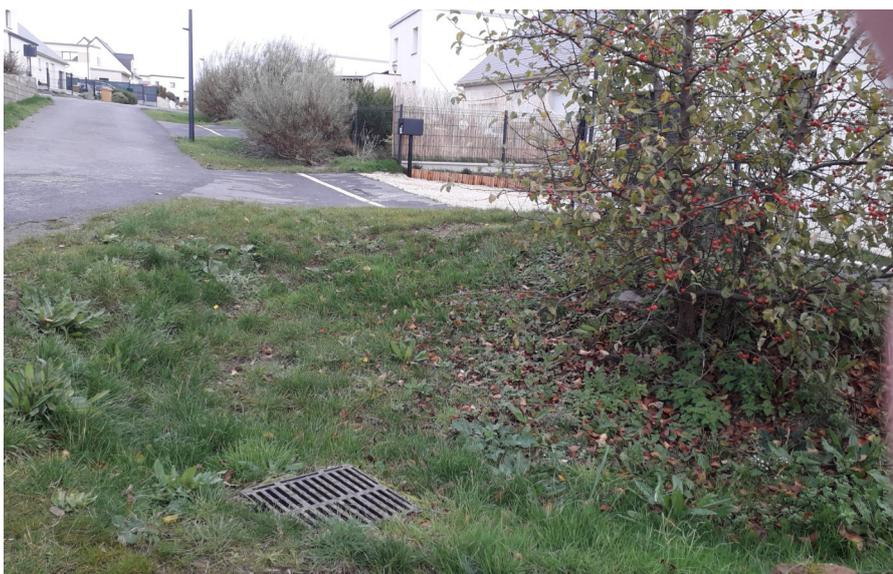
La continuité hydraulique entre les noues est assurée par une surverse de sécurité en aval
