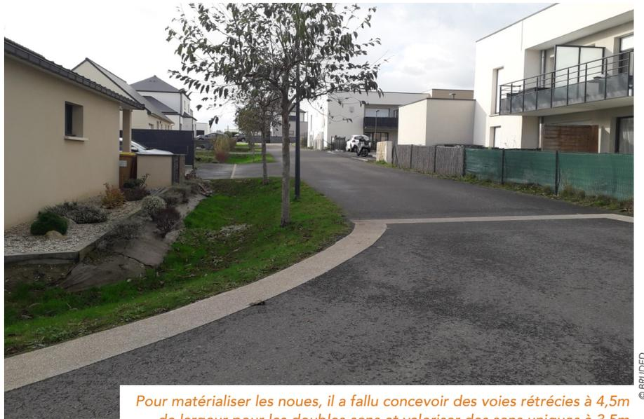
Pour matérialiser les noues, il a fallu concevoir des voies rétrécies à 4,5m de largeur pour les doubles-sens et valoriser des sens uniques à 3,5m
