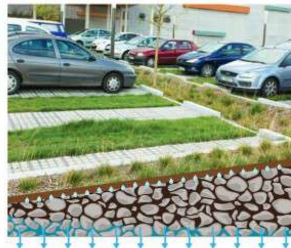
Parking en dalles-gazon et dalles-pavés
