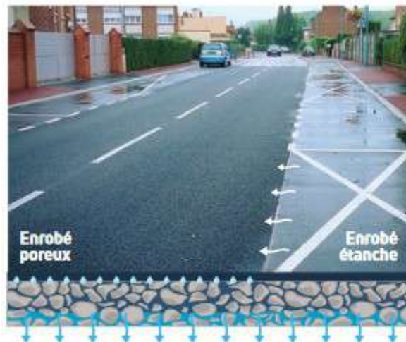
Chaussée à structure réservoir
