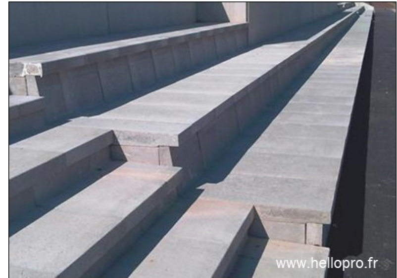
Parvis de la mairie : rampe, escalier et gradin
