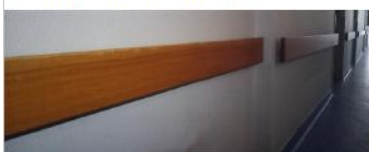
Revêtements de parois
